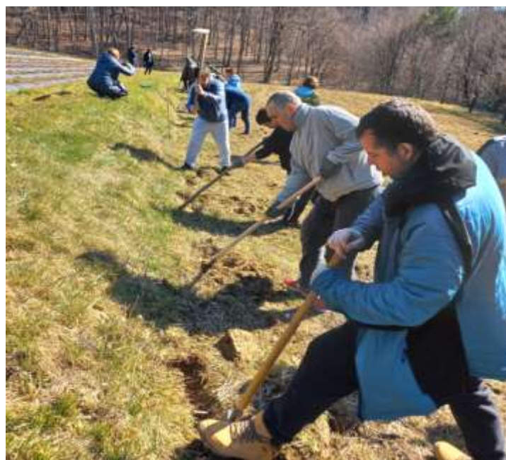
Izdelava travne mulde na kmetiji Vidov brejg, Goričko.
