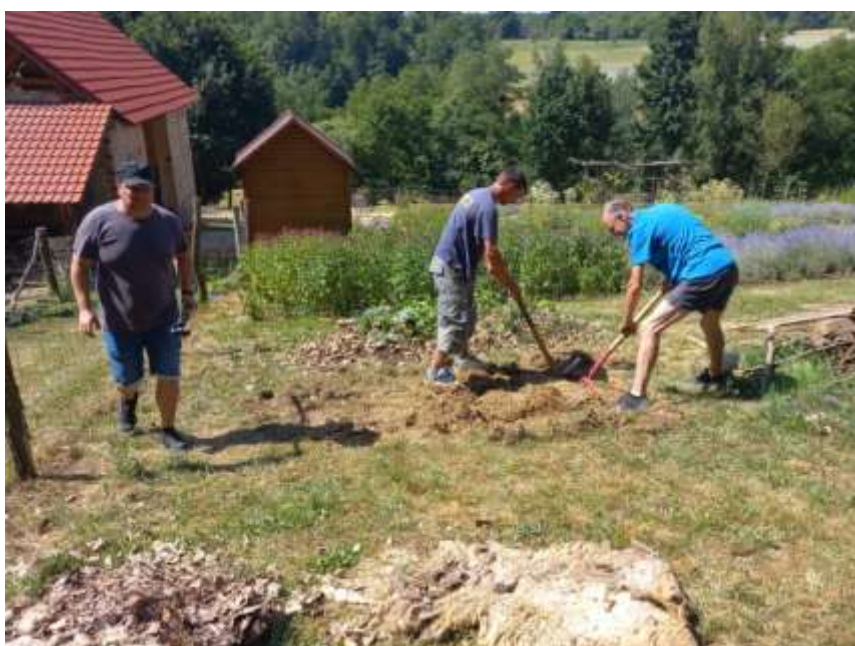
Priprava terena za gredo pogačo.
